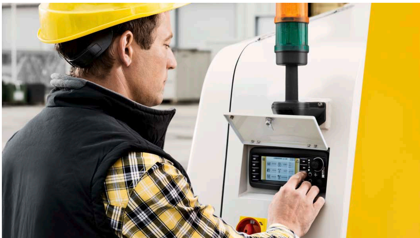
Einstellungssache: Einfache Bedienung am gut zugänglichen Schaltschrank
