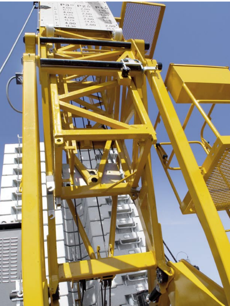
Einklettern von weiteren Turmstücken für mehr Hakenhöhe.
